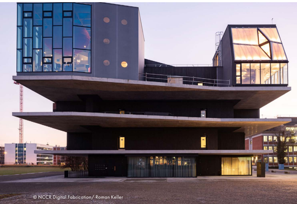
Das «DFAB HOUSE» im NEST in Dübendorf wurde komplett von Robotern und mittels 3D-Druck gebaut.
